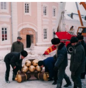
Установка шпиля на главном корпусе Пушечного двора
