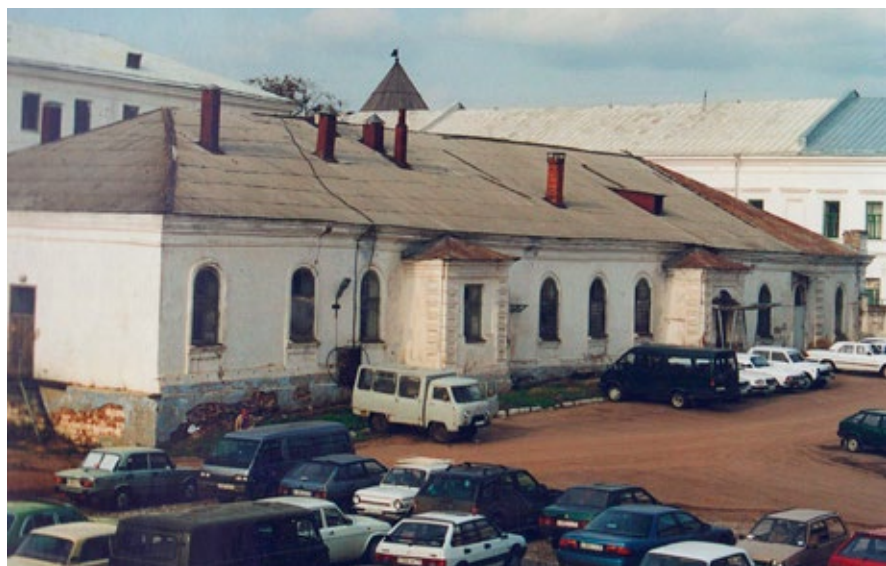
Вид на здание манежа до реставрации
