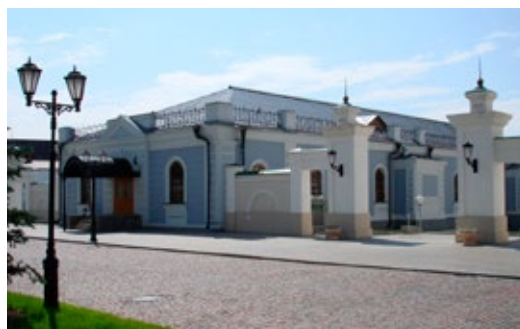
Здание Манежа после реставрации
