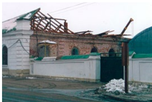
Здание манежа в процессе проведения реставрационных мероприятий
